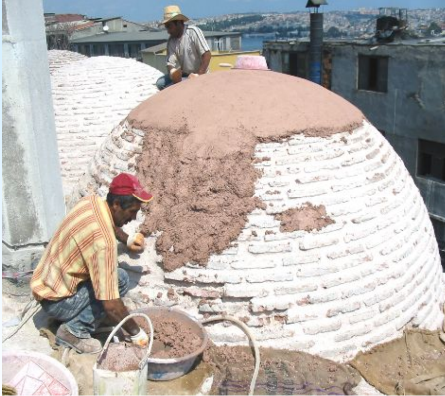
7. Kubbelerin horasan harcı ile sıvanması
